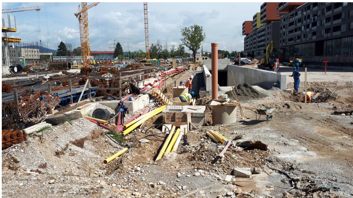
Slika 19: Fotografija z gradbišča v območju
