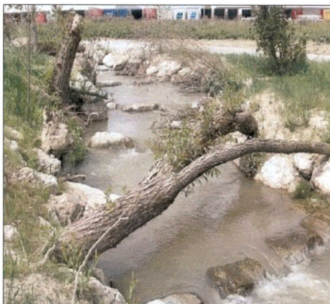
Slika 3: Primer izvedbe izrazito nepravilnih utrjenih brežin in neploščatega kamna (privzeto iz Grundlagen für einen österreichischen Leitfaden zum Bau von Fischaufstiegshilfen (FAHs). Bundesministerium für Land- und Forstwirtschaft, Umwelt und Wasserwirtschaft, Wien, 2011).
