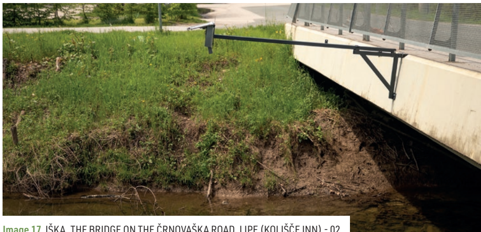
Image 17 IŠKA, THE BRIDGE ON THE ČRNOVAŠKA ROAD, LIPE (KOLIŠČE INN) - 02
