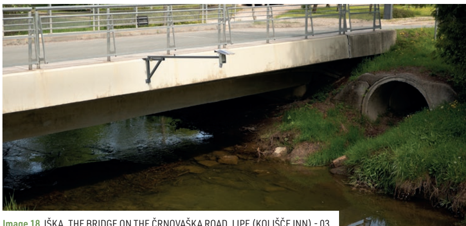
Image 18 IŠKA, THE BRIDGE ON THE ČRNOVAŠKA ROAD, LIPE (KOLIŠČE INN) - 03
