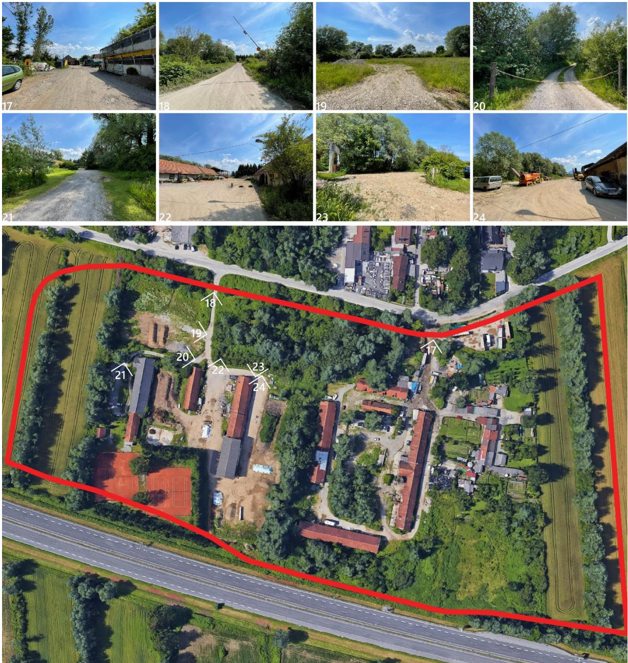
Slika 4: Sklop 2: Fotoanaliza obstoječe stanja območja OPPN 305.
