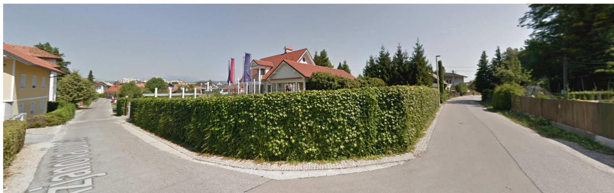
Slika 22 - Pogled 8: Pogled iz JZ roba območja proti JV robu (cesta Pod hribom) (vir: Google Maps)
