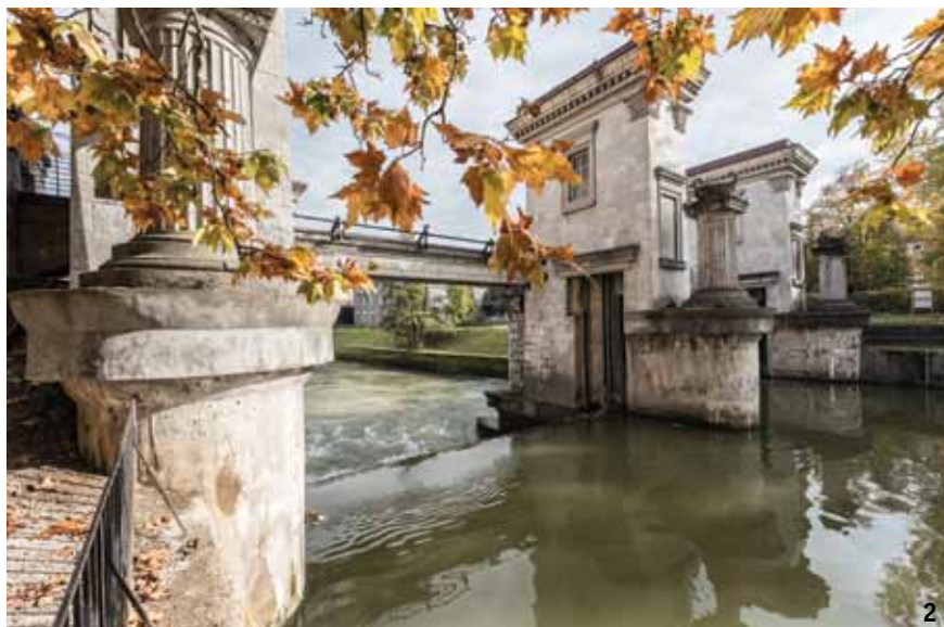
2 Rečna zapornica na Ljubljanici (foto: B. Zupančič). Sluice on the Ljubljanica River (photo: B. Zupančič).
