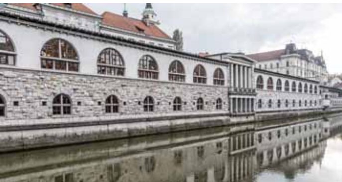
▼ Rečno pročelje Plečnikovih tržnic (foto: B. Zupančič). River facade of Plečnik's covered market (photo: B. Zupančič).
