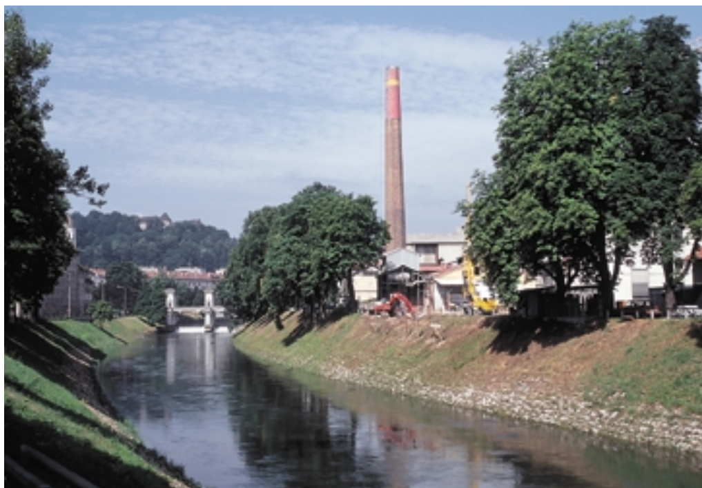
Slika 5-9: Zavarovani kostanjev drevored se umika novi gradnji
