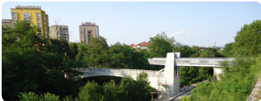
Obnovljeni nadhod čez Gruberjev kanal in železniško progo v podaljšku Streliške ulice na Hrdeckega cesto z dvigalom za gibalno ovirane.
