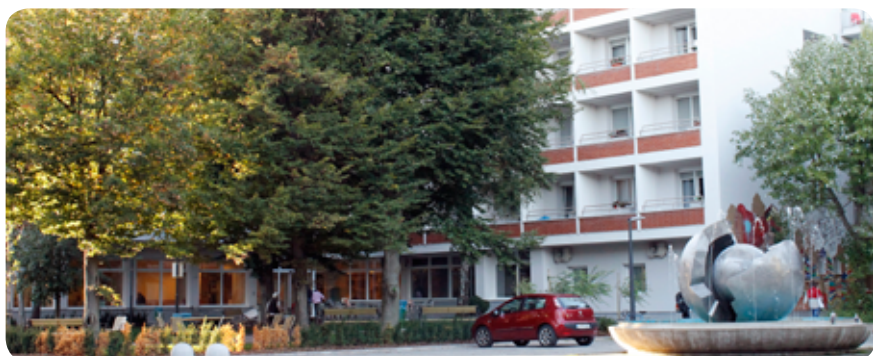
Pogled na del prenovljenega območja, ki zajema Ulico Tabor z novo prometno ureditvijo in Rozmanovo ulico. Prenova zadnjega dela Maistrove še poteka.
