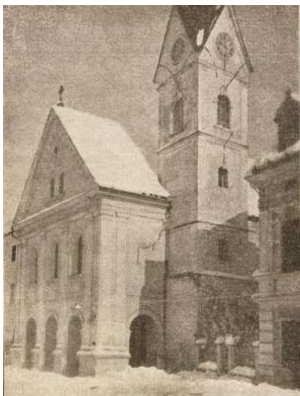
Slika 18: Poškodovana cerkev Sv. Helene v Brežicah.
