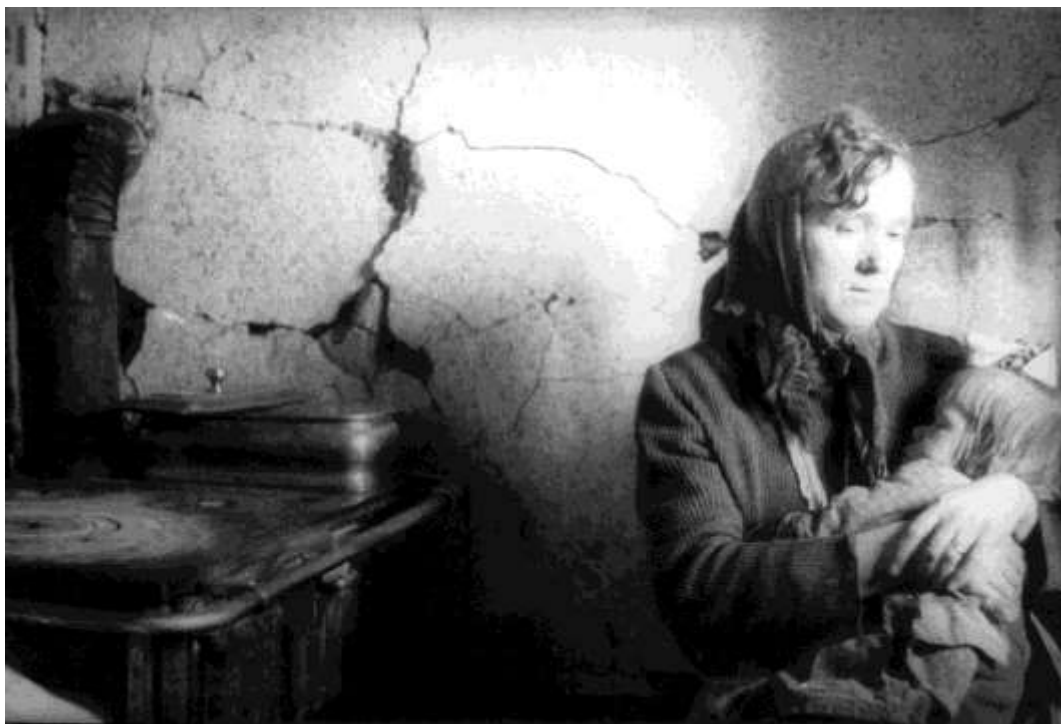
Slika 19: Poškodbe ob ilirskobistriškem potresu.
